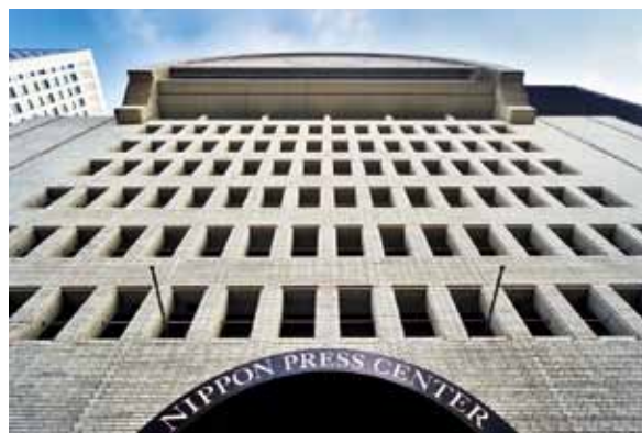
日本新聞協会が入る日本プレスセンタービル photo: 加藤雅昭 / HJPI320110001771
